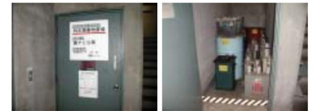
各地区では、人為的ミスや災害時に化学物質の漏洩事故が発生した場合を想定し、対応手順を作成し、定期的な設備点検と訓練実施により、万一の事故発生時に備えています。昨年6月、厚木地区では保管している廃酸を入れたケミカルドラム缶の天板が破裂する事故が発生しました。幸いにも人的被害はなく、また、保管場所は化学物質の流出・漏洩防止対策を実施していたため、外部流出、地下浸透の発生もありませんでした。原因は、ドラム缶内部での化合反応によりガスが発生したためと推定されました。対策として、すべての廃液成分調査を実施し、混合による危険性がある廃液は単独で保管するように改善し、規程に反映するとともに、教育を実施するなど再発防止対策を行いました。
