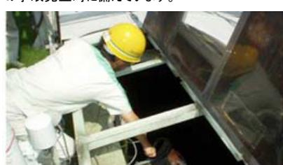
緊急遮断弁の閉止
