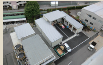
2014 年度 固形廃棄物置場および危険物倉庫の新設
