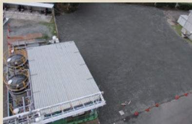
2013 年度 工程系排水処理設備の新設および 旧設備の解体
