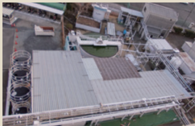
2012 年度 旧工程系排水処理設備
