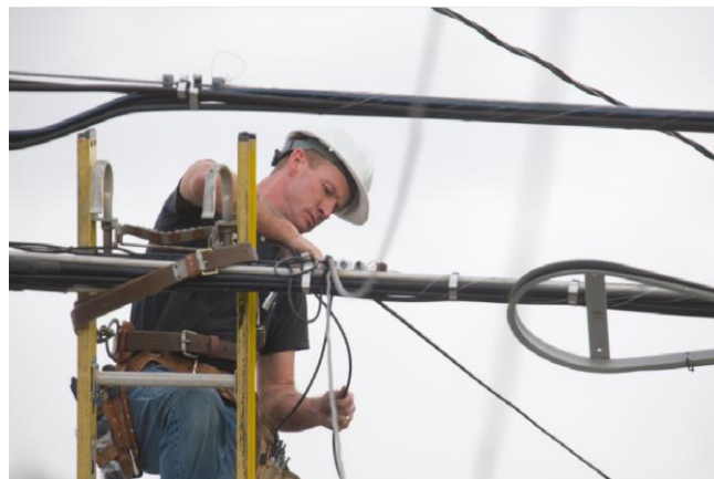
光通信の建設・保守を支える
