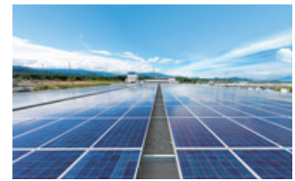
郡山第二事業所の太陽光発電設備
