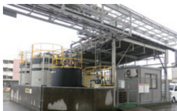
工程系排水処理設備全体
