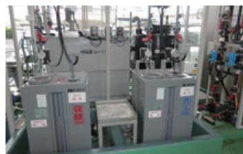
工程系排水処理設備の中和処理部分
