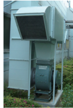
排気口の消音対策
