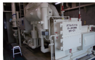
ターボ冷凍機
