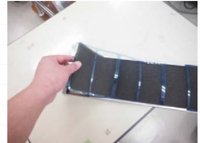
図4 フィルタ(外して清掃)
