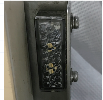
図12 反射板の汚れ
