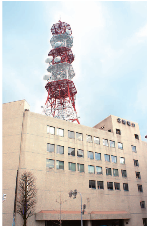
北陸電力 無線鉄塔
