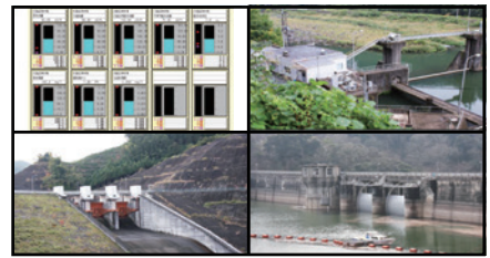
複数の排水ゲート・水位などの一括監視
