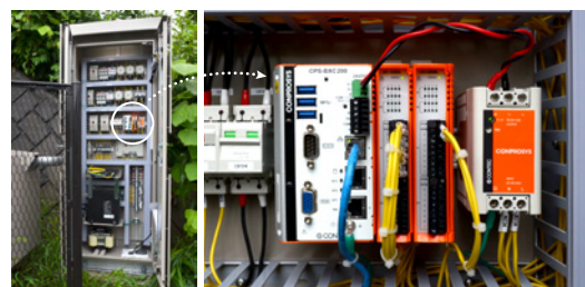
監視盤内部の分散型遠方監視システム
