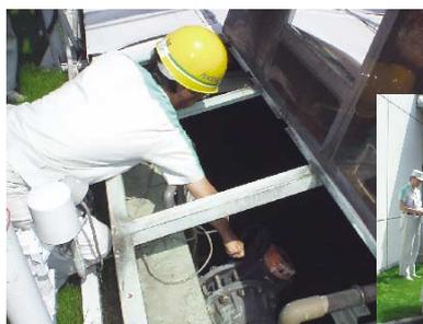
緊急遮断弁の閉止
