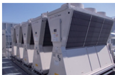
グローバル本社棟 高効率空調機
