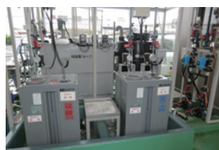
工程系排水処理設備の中和処理部分
