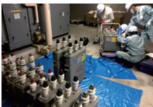
PCB含有コンデンサ搬出の様子
