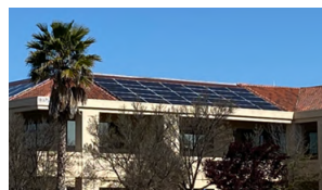
建設中の太陽光発電設備(米国)
