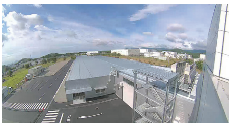
第二工場に増設した新棟
