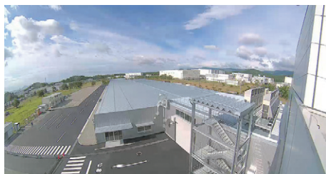
第二工場に増設した新棟
