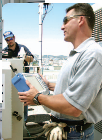
無線基地局 建設・保守用 計測器
