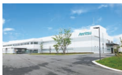
東北アンリツ第二工場(郡山市)
