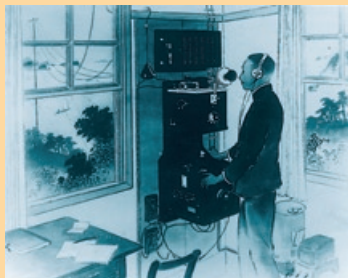
志摩無線電話局内のTYK式無線電話機 (通信総合博物館所蔵)
