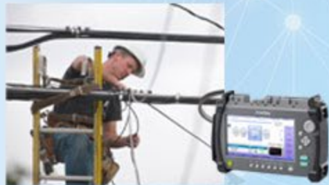
光ファイバーの工事・点検に
