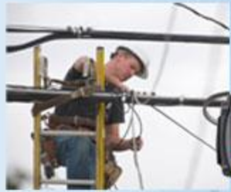
光ファイバーの工事・点検に
