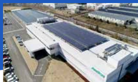
東北アンリツ第二工場
