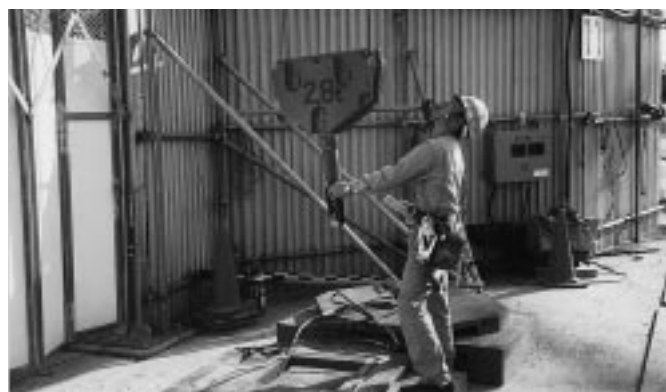
図2 クライミングクレーンの操作 Operation of climbing crane
