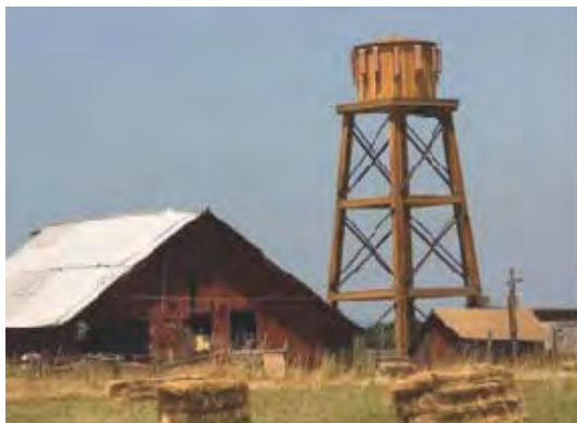
生锈的屋顶和栅栏可能会成为无源互调的主要潜在源
